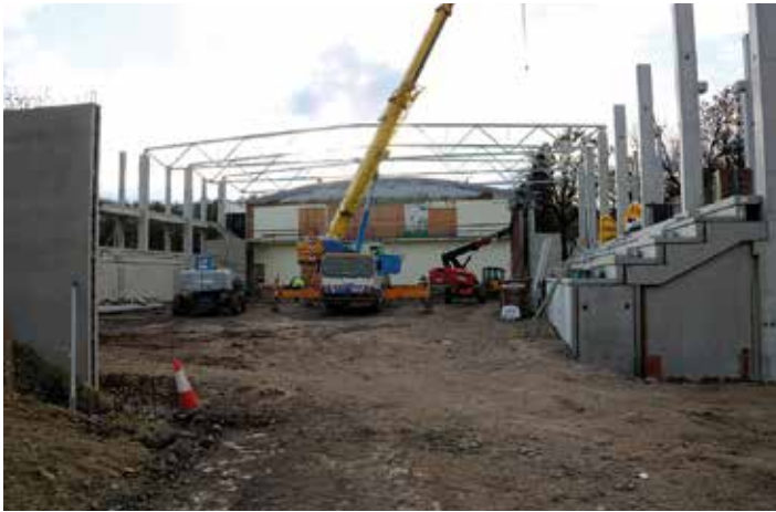
Budowa nowej hali
