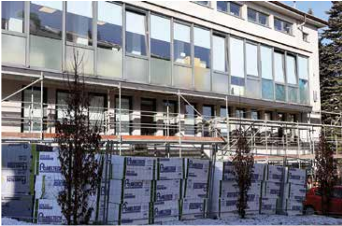
Prace remontowe w budynku KB
